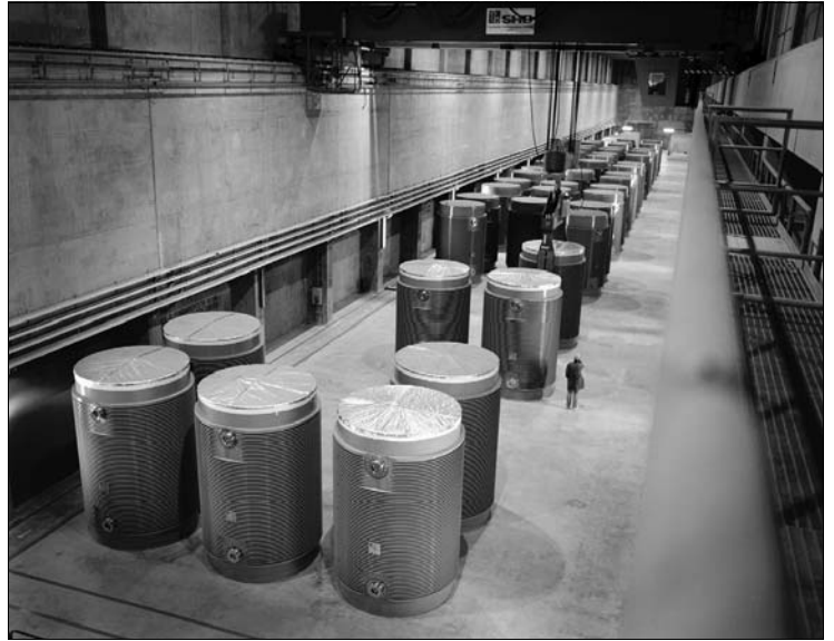
In Castor-Behältern warten die Brennstäbe auf ein Lager, das es nicht gibt.
