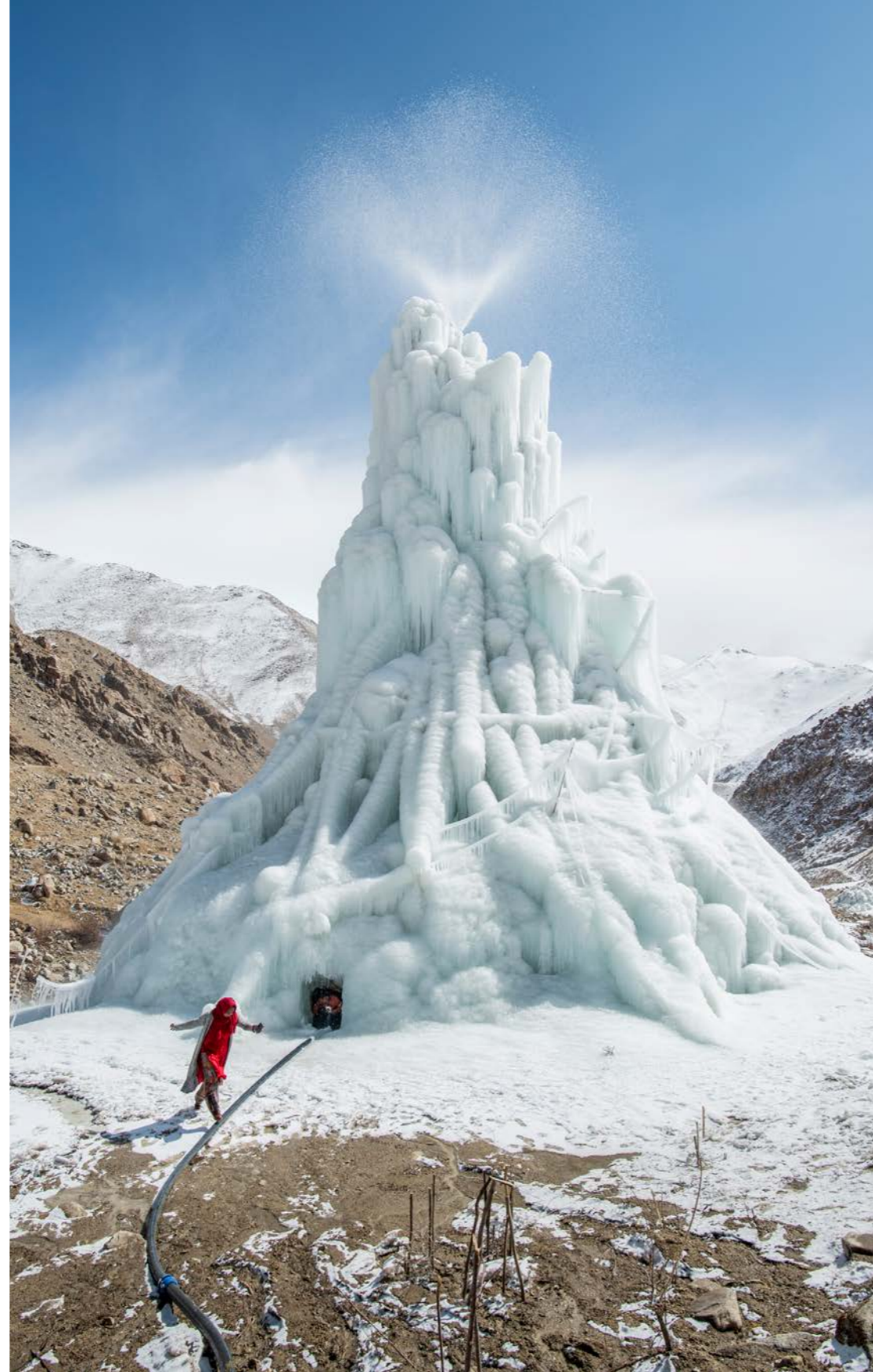
Ein Schlauch leitet Wasser aus größerer Höhe zum Eisstupa. Es steigt im Innern zur Spitze, zerstäubt, gefriert in der kalten Luft und lässt den Turm wachsen. Den nötigen Wasserdruck liefert allein die Schwerkraft
