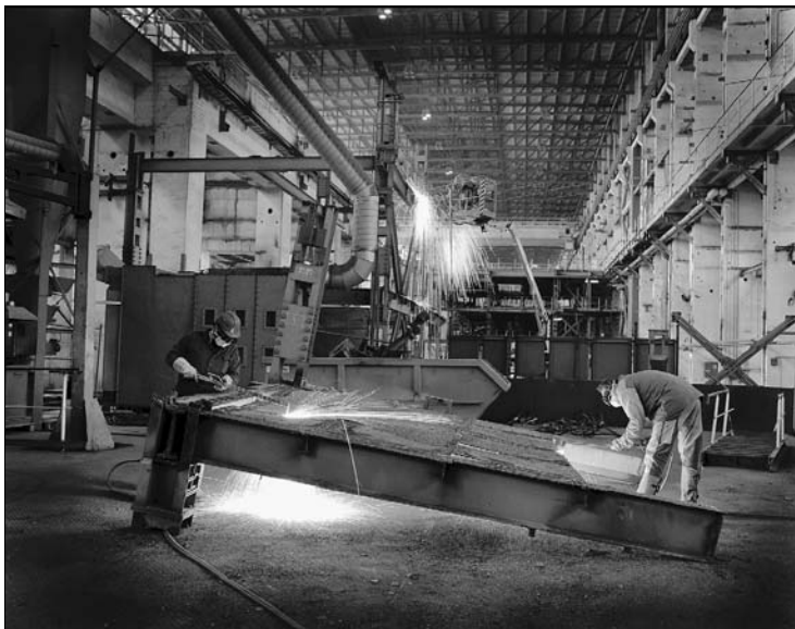
Soll-Abbruchmenge pro Mann und Tag im nicht verstrahlten Bereich: 553,6 Kilo.
